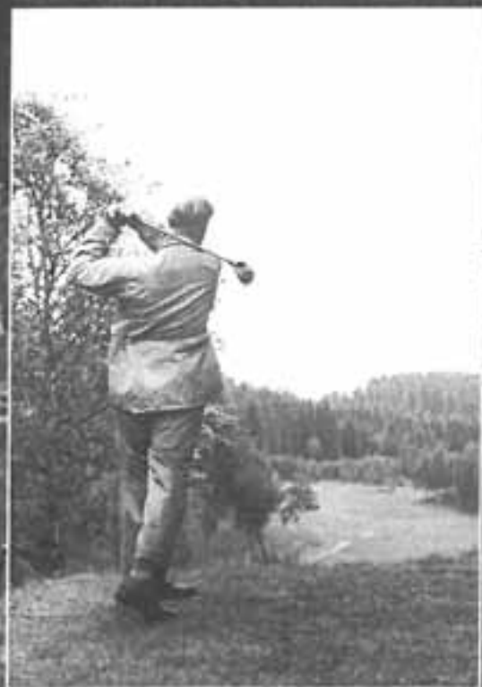
Utslag på Himstadjordet
