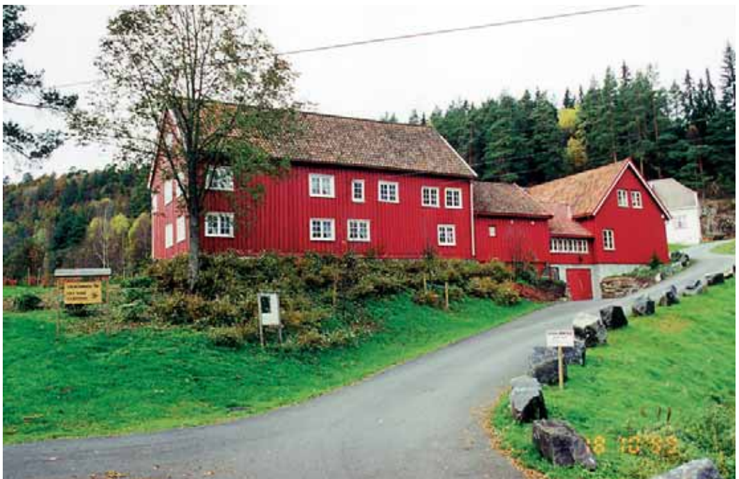
Den nye oppkjørselen fra Vålandsveien til AOGKs lokaler på Nes Verk. Vi ser Slettahuset t.v., det nye servicebygget i midten og det hvitmalt klubbhuset lengst t. h.
