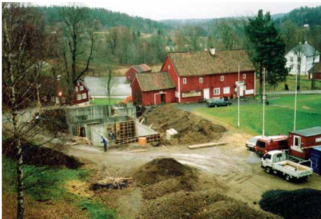
Her er arbeidet med det nye service- og aktivitetsbygget i full gang. Det sto ferdig i 1998.
