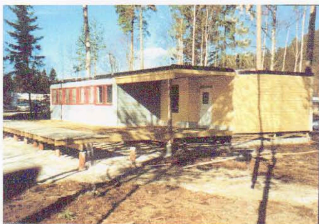
Klubbhuset under bygging i 1997
