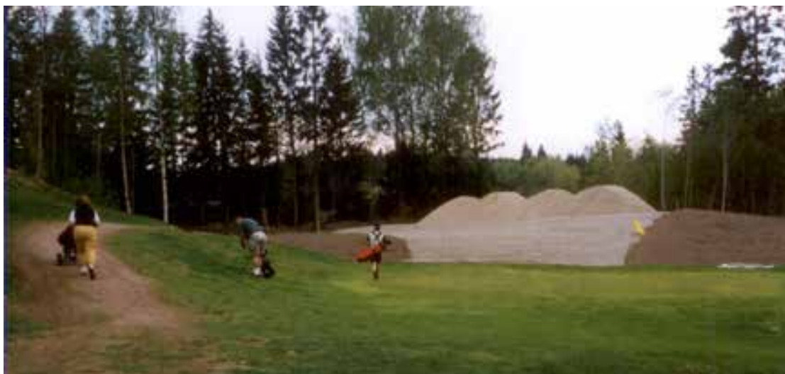
Fra ombyggingen av hull 4 i 2000.
